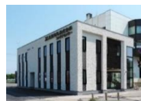
北見通運㈱コンテナセンター2階
